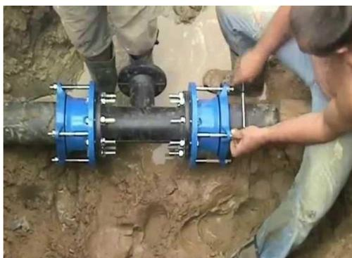
1 — корпус: ковкий чугун GGG50 с эпоксидным порошковым покрытием.
