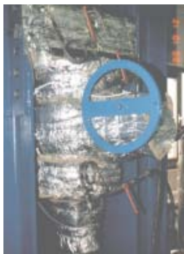
Шаровой кран «Баллостар»: испытание по EN 488
