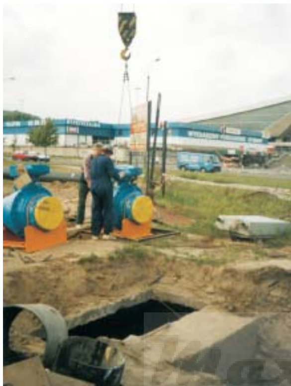
Установка шарового крана «Баллостар» KHSVI в Польше
