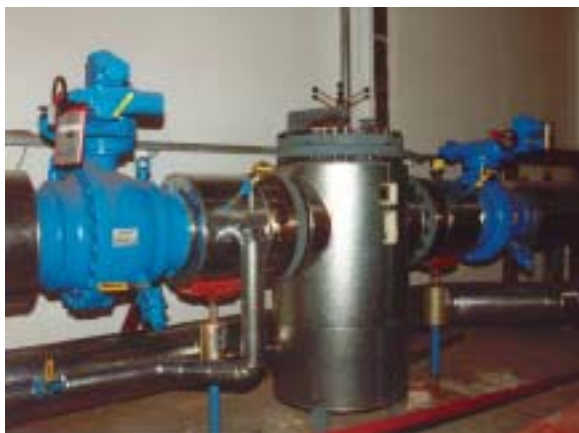
Шаровой кран KNI в теплосети
