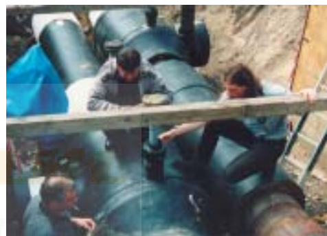
Предизолированный шаровый кран «Баллостар»: до, во время и после установки на трубопроводе.
