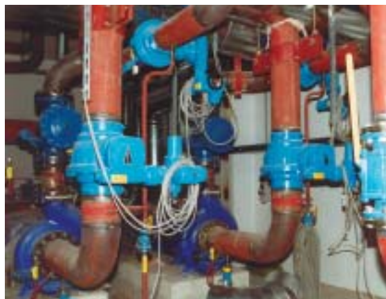
Шаровой кран KNI в теплосети
