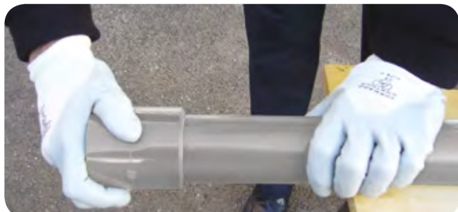
7. Удалите лишний клей с внешней поверхности соединения.
