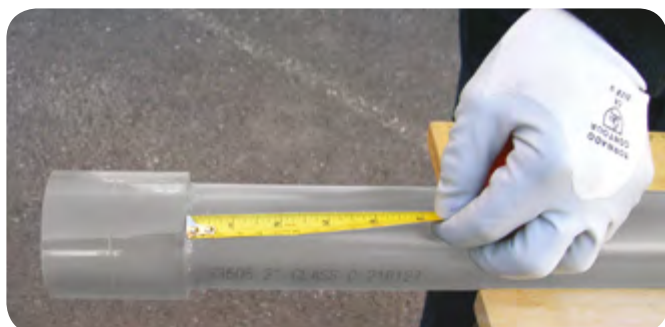
8. Убедитесь, что труба полностью вставлена в гнездо, используя предварительно сделанную метку
