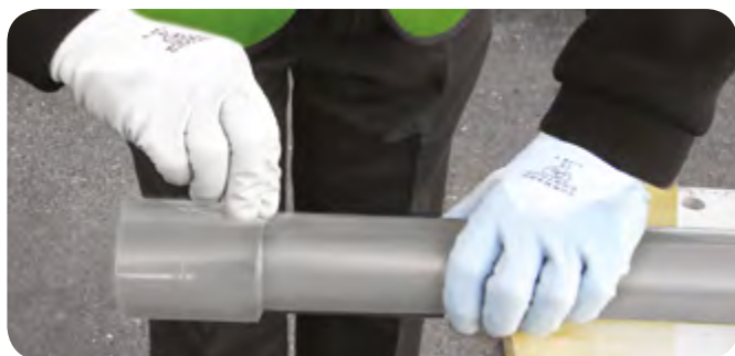
8. Убедитесь, что труба полностью вставлена в гнездо, используя предварительно сделанную метку
