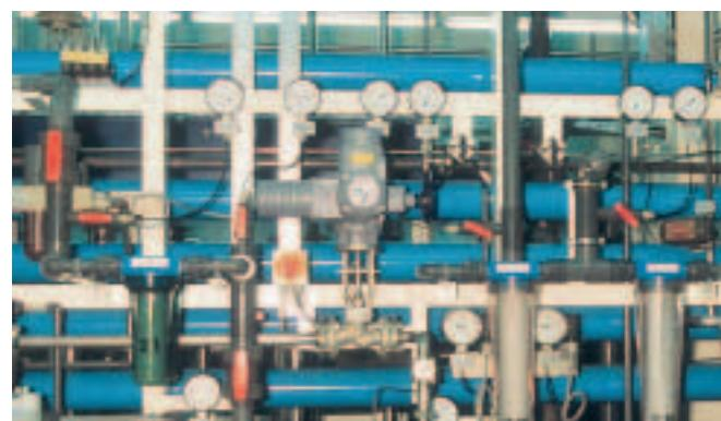
Привод AUMA, работающий в режиме регулирования. Смонтирован на регулирующую задвижку на опреснительном заводе.
